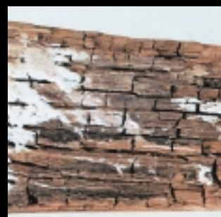
Porenschwamm-Schaden
