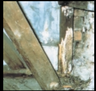
Kellerschwamm-Schaden
